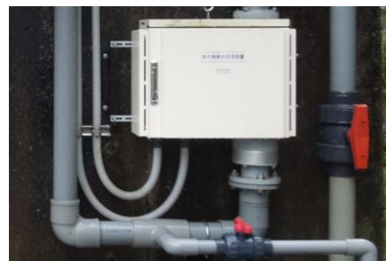
100L/min.紫外線流水殺菌装置と排水処理へ適用した実績例
